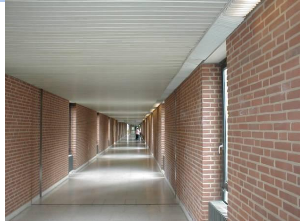
Abb.: Flur mit abgängigem Lichtband
