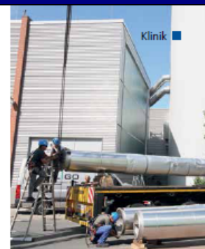
Die bis zu 25 Meter langen Röhren wurden jeweils einzeln angekettet ...
