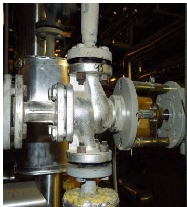
Alte Strahlpumpenanlagen
