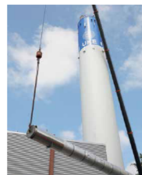
... von dem mobilen Spezialkran hochgezogen (o.) und in den Schornstein eingelassen (u.)
