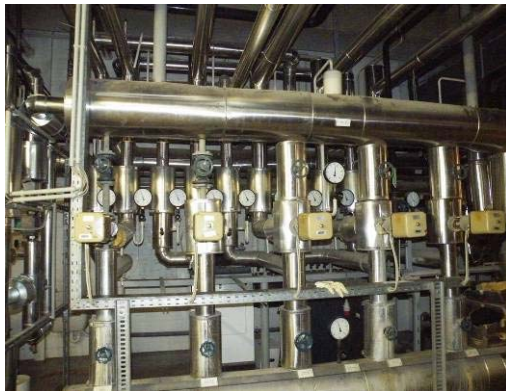
Alte Strahlpumpenanlagen
