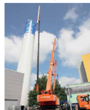
... von dem mobilen Spezialkran hochgezogen (o.) und in den Schornstein eingelassen (u.)
