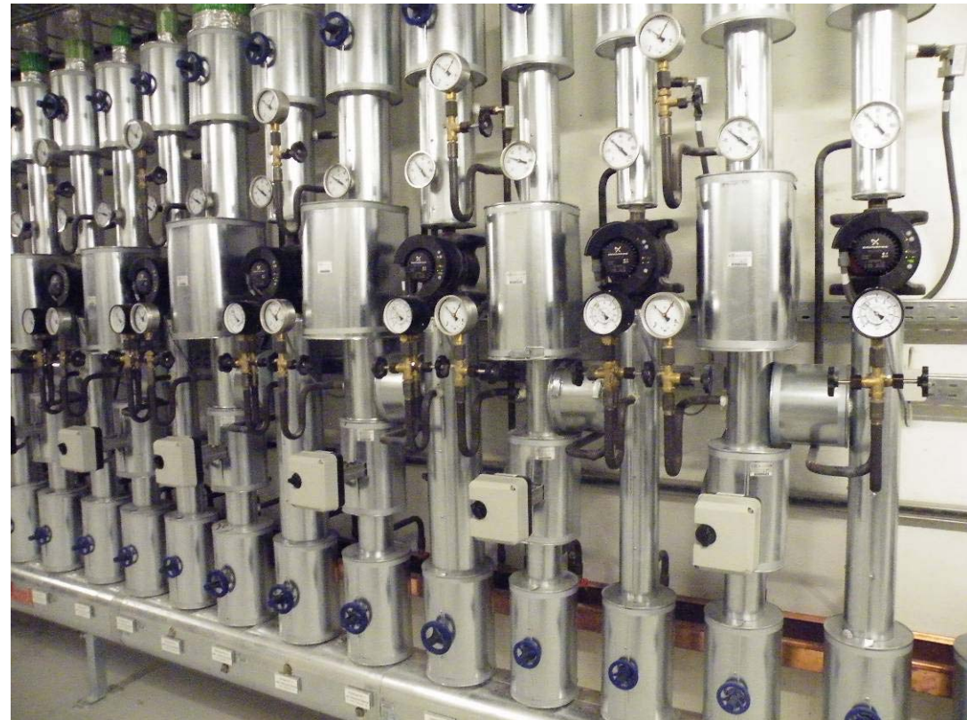
Neue Umwälzpumpen mit Beimischregelung
