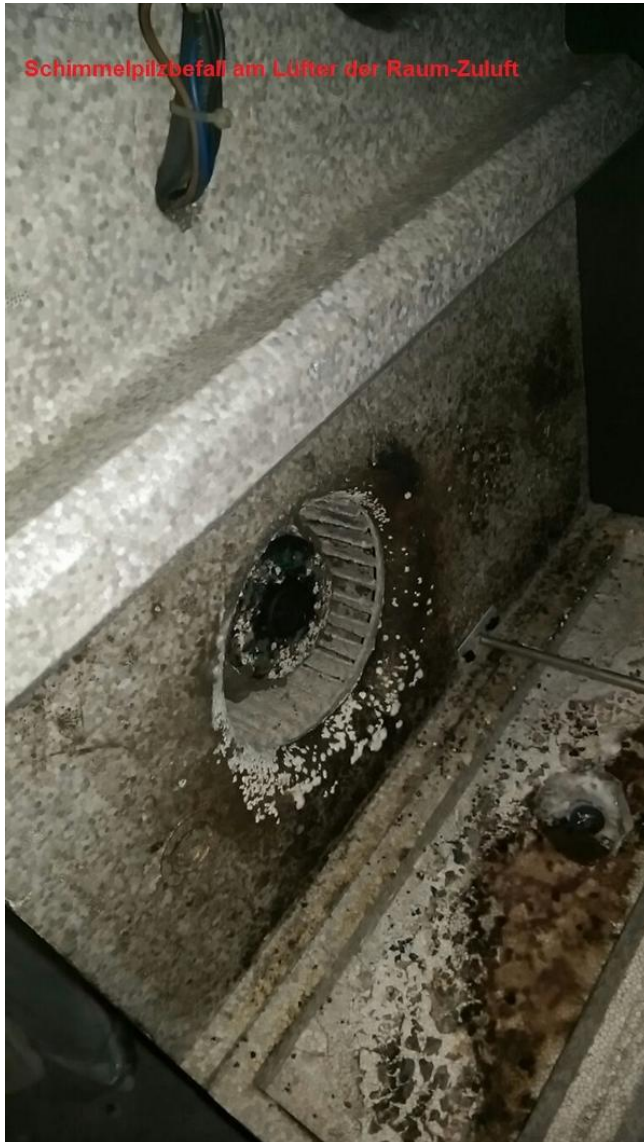
Schimmel-Befall Lüfter Raum Zuluft
