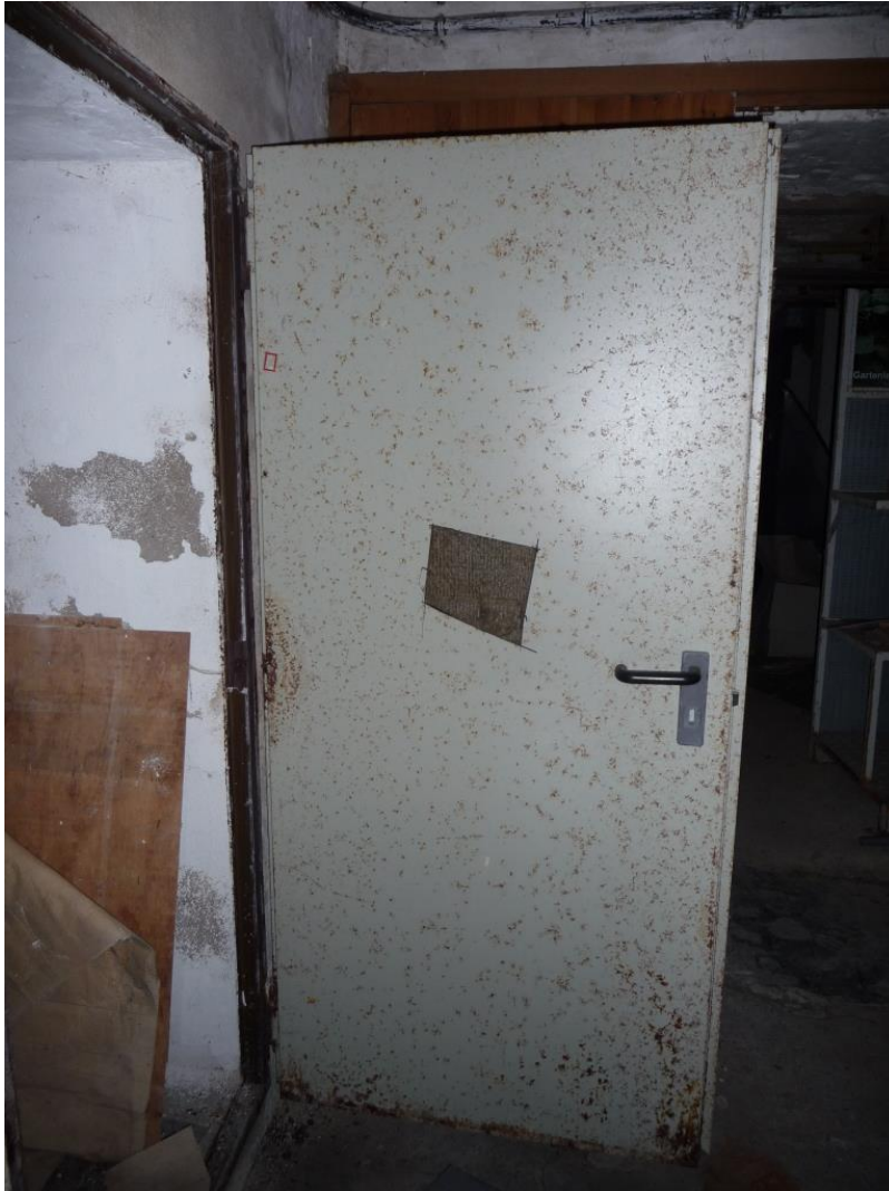
Brandschutztür aus Asbest
