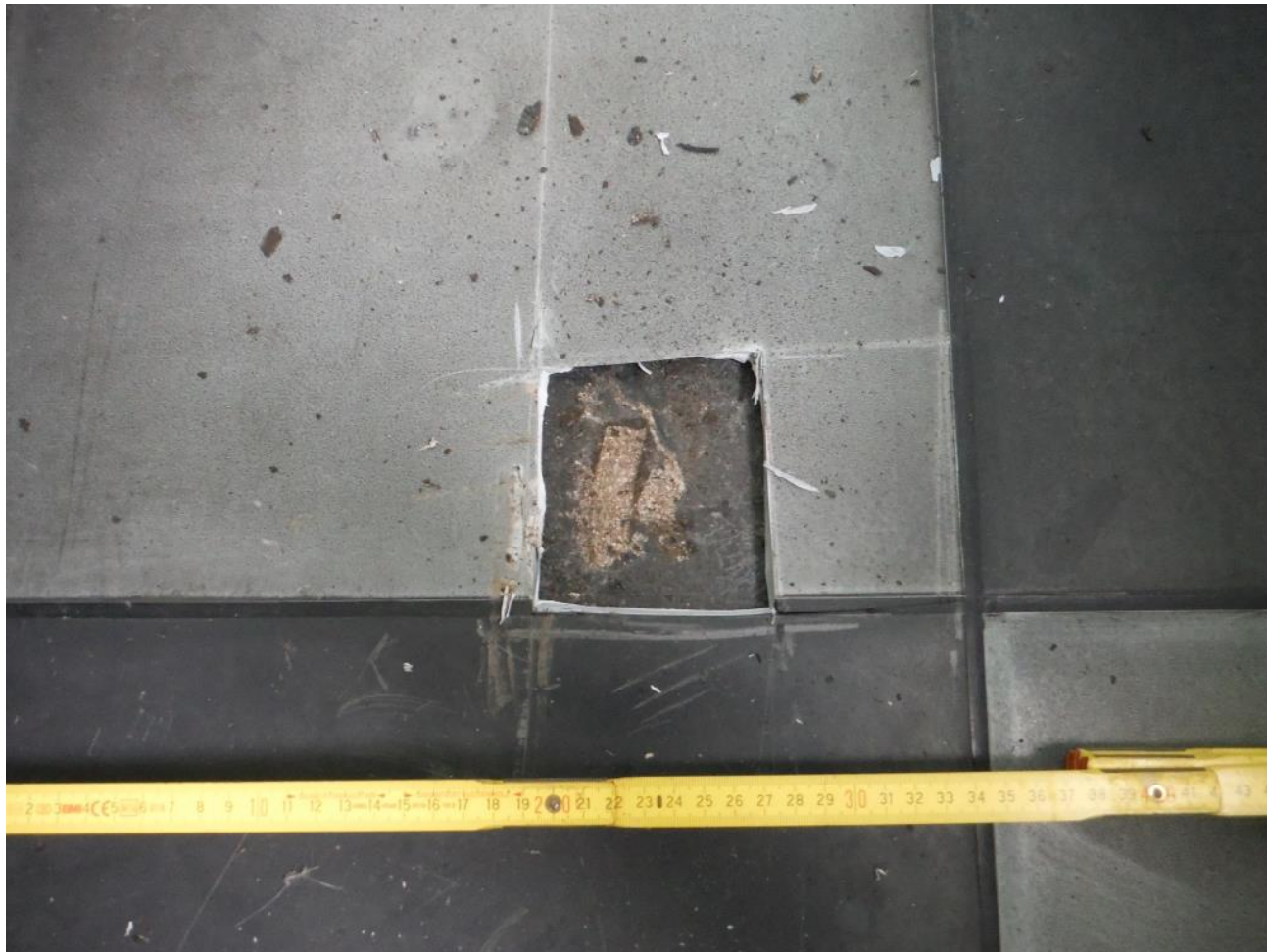
Asbesthaltiger Bodenbelag
