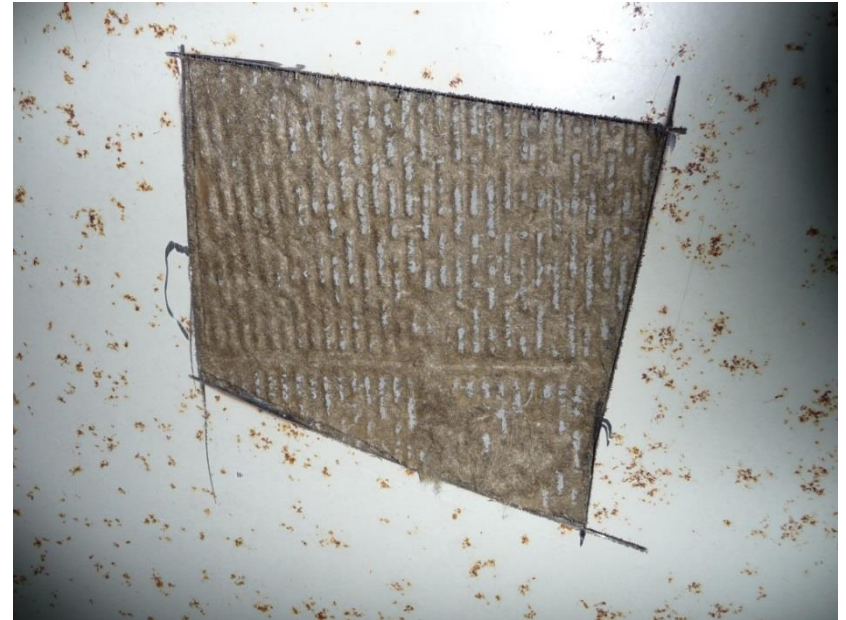
Nahaufnahme Türdämmung
