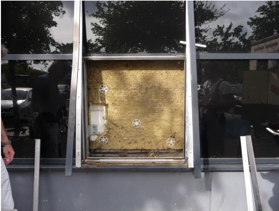
Dämmung (KMF)
