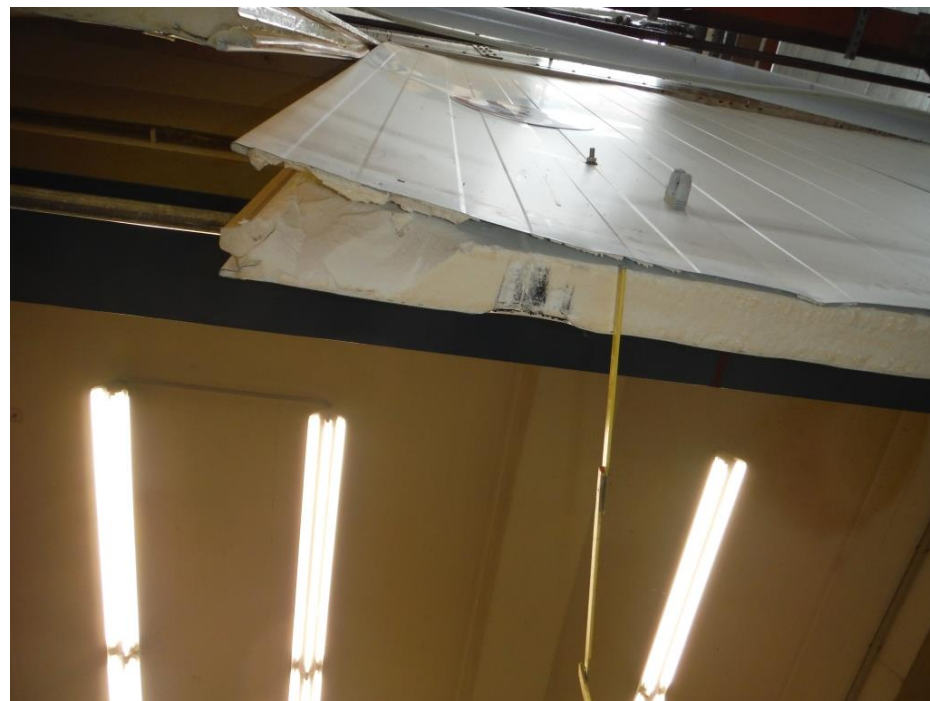
Nahaufnahme Dämmmaterial Trennwand (KMF)
