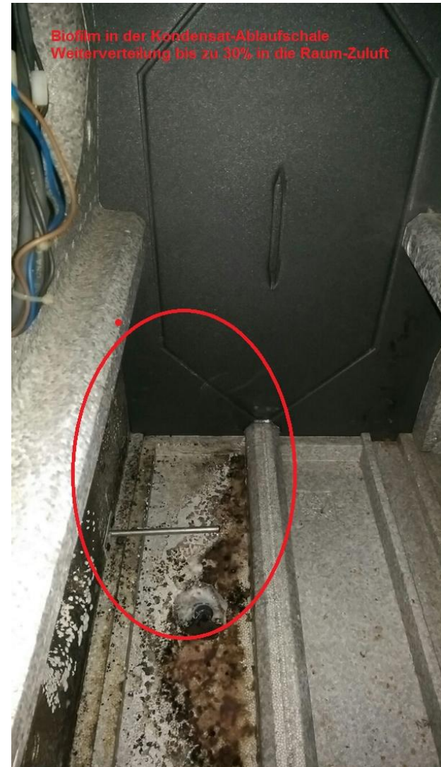
Biofilm in Kondensat-Ablaufschale
