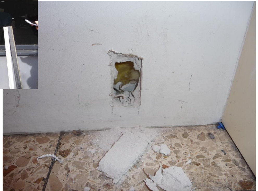
Dämmung (KMF)
