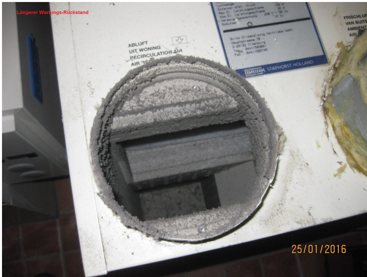
Längerer Wartungs-Rückstand (Abluft)
