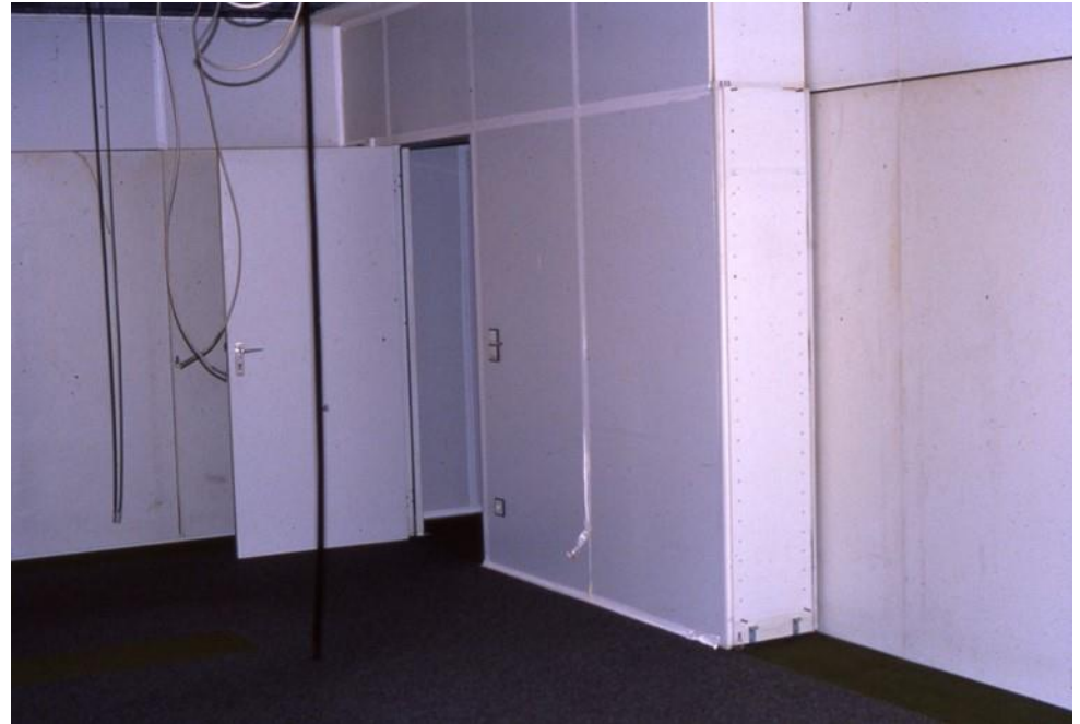
Asbest-Wände, Systemtrennwände
