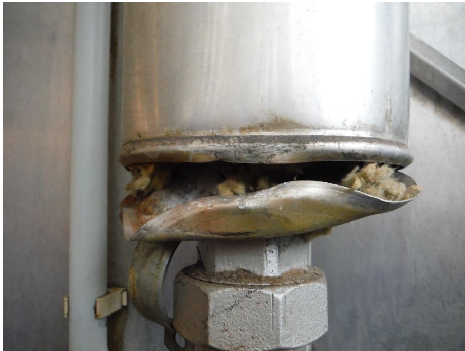
Dämmung Hauptdampfleitung
