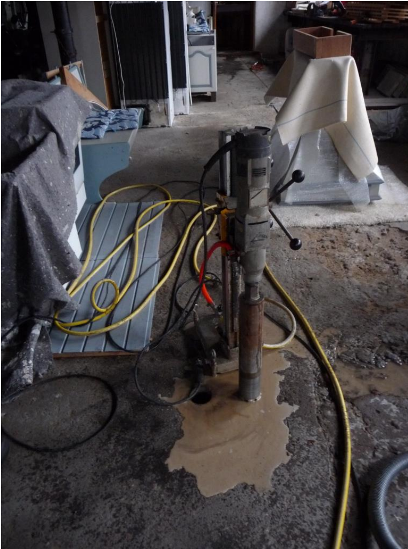
Entnahme Bohrkern
