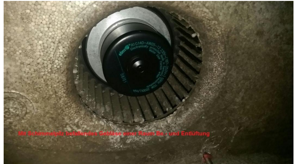
Mit Schimmelpilz befallenes Gebläse einer Be- und Entlüftung
